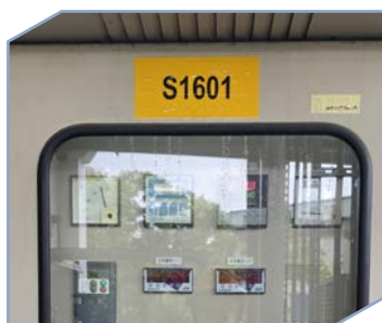
16 區 50HP 排氣風車 S1601 頻率調整
