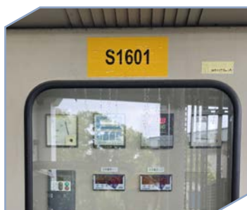
16 區 50HP 排氣風車 S1601 頻率調整
