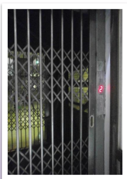
升降梯連鎖裝置修復完成
